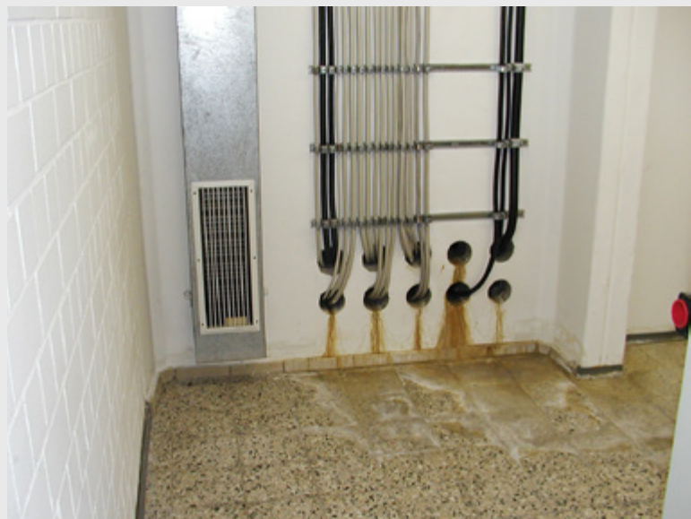
Bild 2: Undichte Kabeldurchführung
