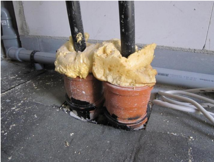
Bild 4: Nicht fachgerecht abgedichtete KG-Rohre*
