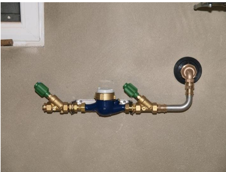
Bild 11: Wasserhauseinführung MIS 90 Innenansicht
