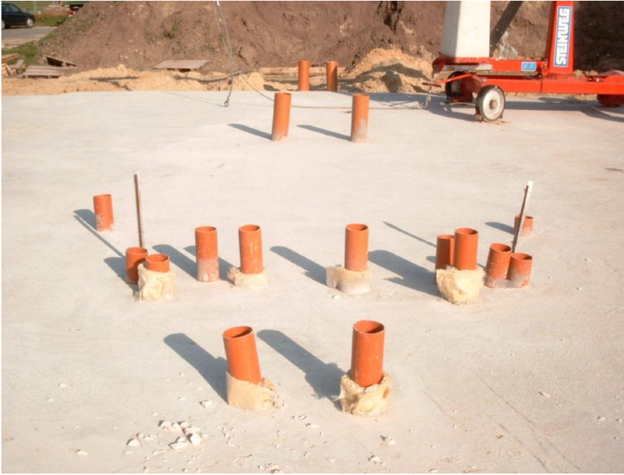
Bild 3: Problematisch - KG-Rohre als Hauseinführungen
