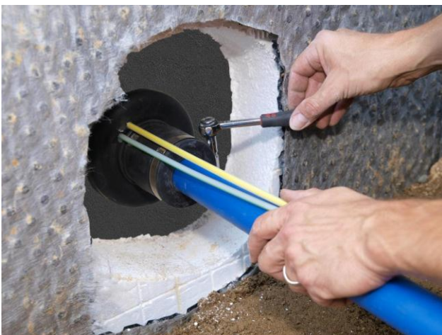
Bild 19: Wasserhausanschluss und Mitverlegung von Micropipes (Außenansicht)
