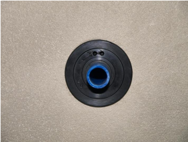
Bild 18: Wandabschluss-Rosette wird aufgesteckt
