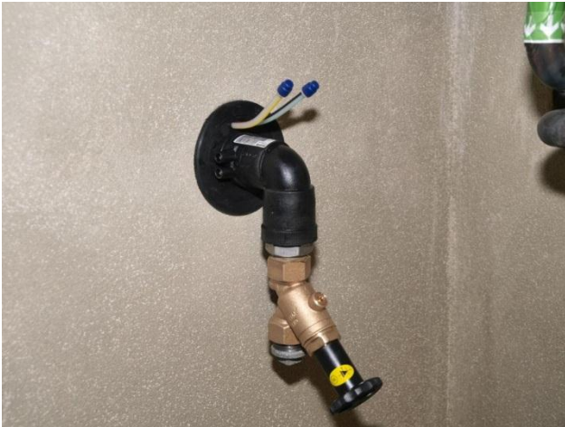
Bild 20: Wasserhausanschluss und Mitverlegung von Micropipes (Innenansicht)
