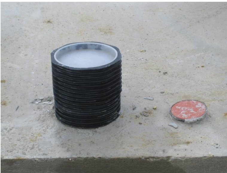
Bild 7: Einbetonierte Grundkörper (Rohbauteil)
