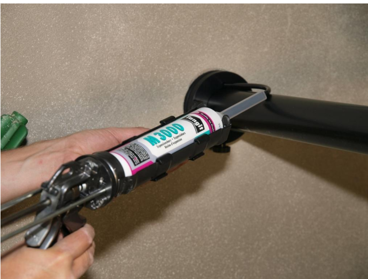
Bild 15: Expansionsharz Tangit M 3000 wird injiziert
