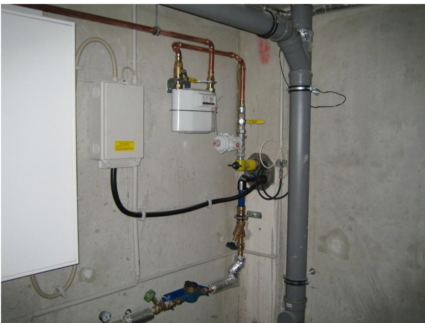
Bild 2: Mehrspartenhauseinführung (Innenansicht)
