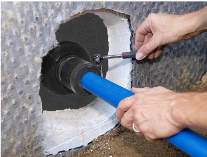
Bild 10: Wasserhauseinführung MIS 90 Außenansicht
