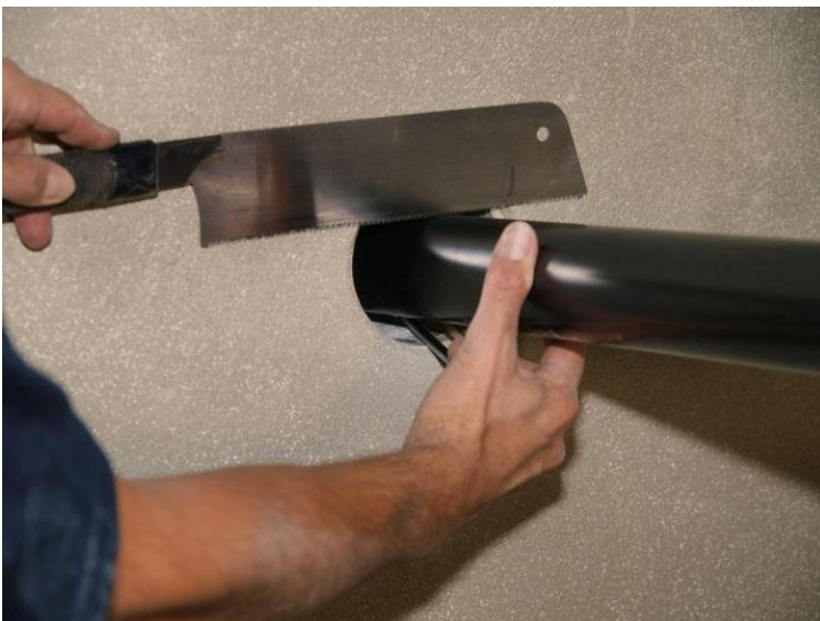
Bild 17: Wanddurchführungsrohr wird eingekürzt
