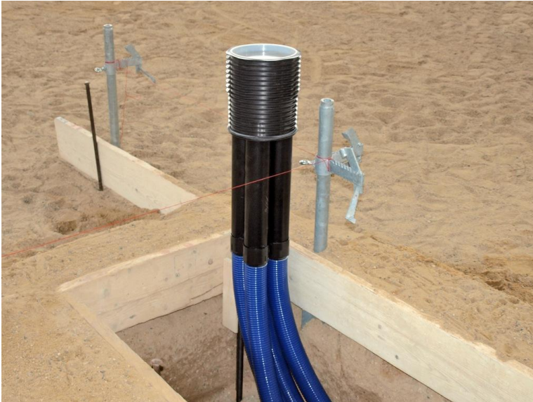
Bild 6: Grundkörper am Schnurgerüst ausgerichtet
