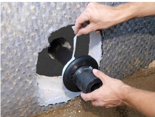
Bild 13: Hauseinführung mit Außenflansch und Butylband
