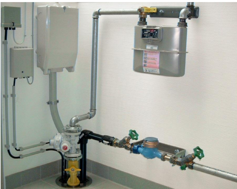
Bild 9: Fertig installierte Mehrspartenhauseinführung*
