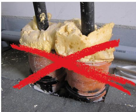
**Regelwerke fordern, dass Gas-, Wasser-, Strom-, Telekommunikations- und Fernwärmeleitungen gas- u. wasserdicht in Gebäude eingeführt werden müssen! Anforderungen (Auszüge aus wichtigen Regelwerken): \***
