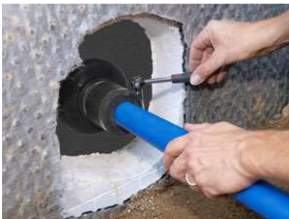
Bild 10: Wasserhauseinführung MIS 90 Außenansicht
