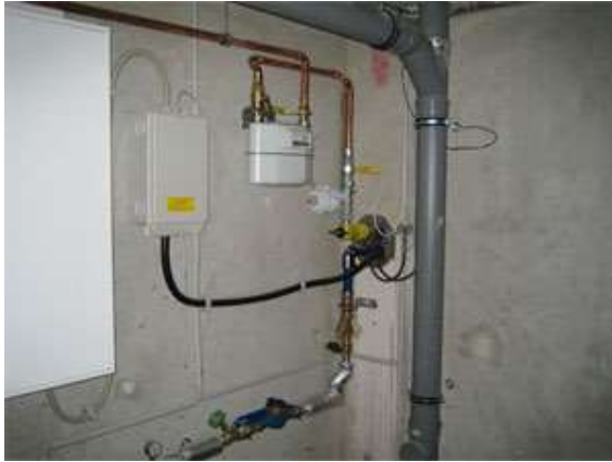
Bild 2: Mehrspartenhauseinführung (Innenansicht)
