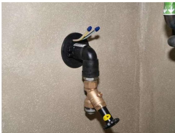
Bild 20: Wasserhausanschluss und Mitverlegung von Micropipes (Innenansicht)
