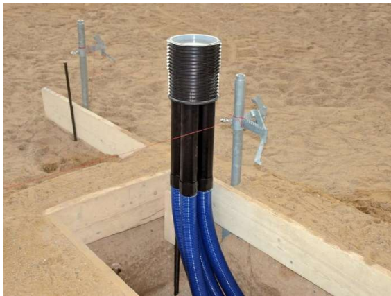
Bild 7: Einbetonierte Grundkörper (Rohbauteil)
