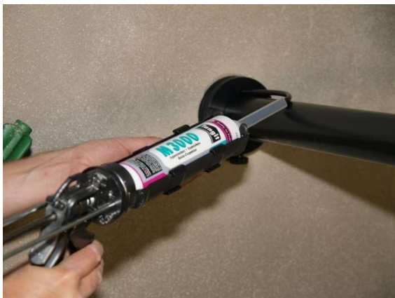
Bild 15: Expansionsharz Tangit M 3000 wird injiziert
