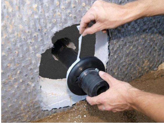
Bild 13: Hauseinführung mit Außenflansch und Butylband
