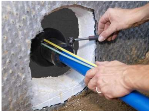
Bild 19: Wasserhausanschluss und Mitverlegung von Micropipes (Außenansicht)
