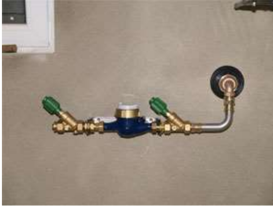
Bild 11: Wasserhauseinführung MIS 90 Innenansicht
