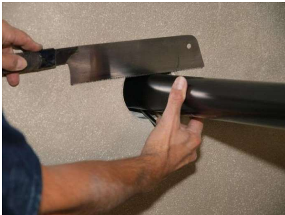
Bild 17: Wanddurchführungsrohr wird eingekürzt
