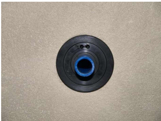
Bild 18: Wandabschluss-Rosette wird aufgesteckt
