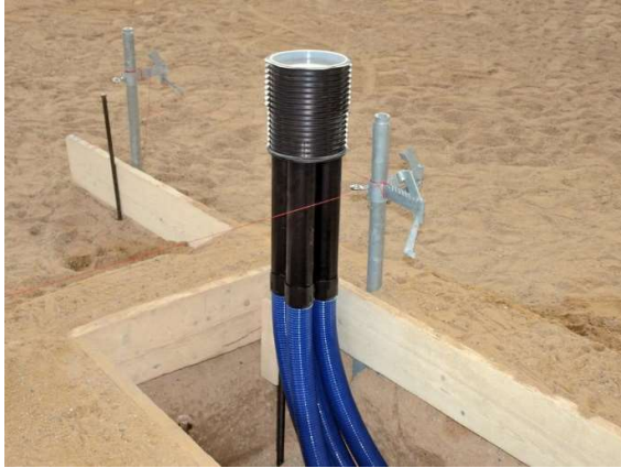
Bild 6: Grundkörper am Schnurgerüst ausgerichtet
